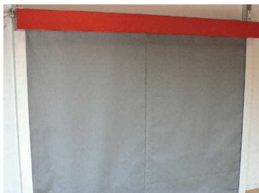
Automatyczna kurtyna dymowa w pozycji Opuszczonej
