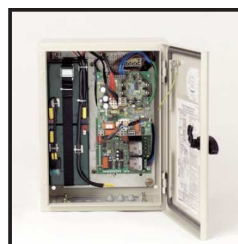
Beolux szafka sterująca z wbudowanym zasilaniem awaryjnym.
